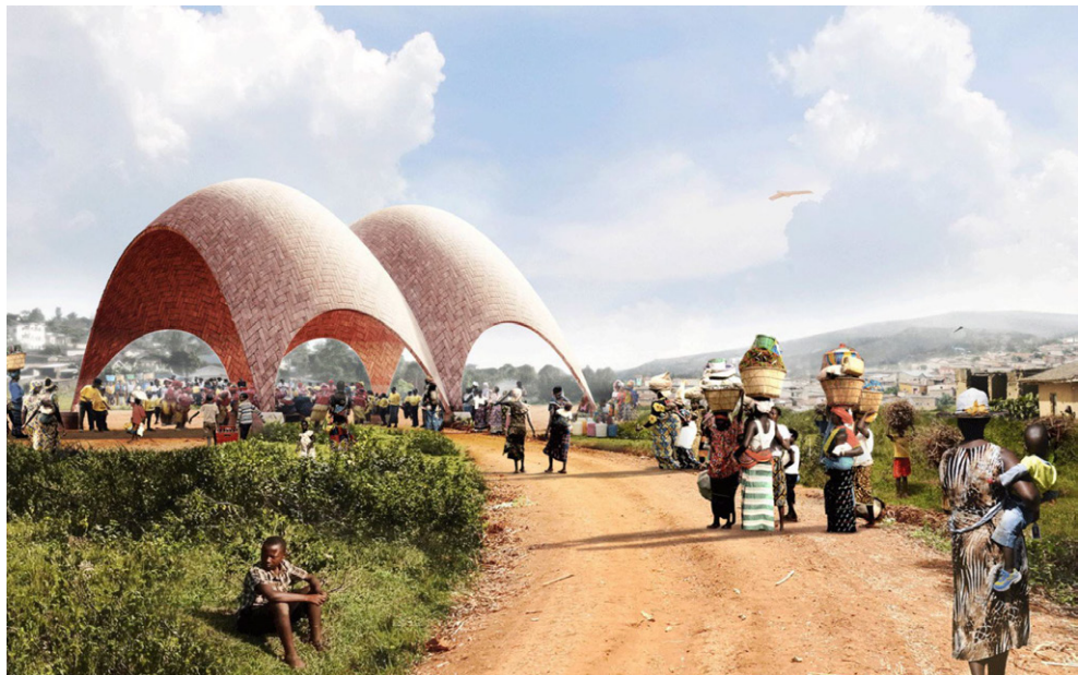
Recreación de la cúpula tabicada que Foster ha ideado para el aeropuerto de drones en Ruanda, siguiendo el modelo de Guastavino.
