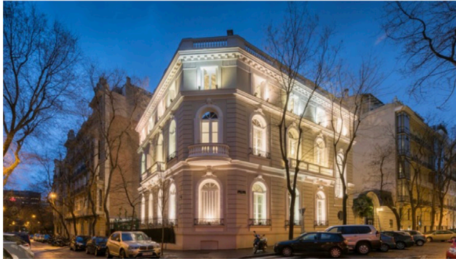
Vue extérieure de la Norman Foster Foundation, Madrid © Courtesy Norman Foster Foundation
