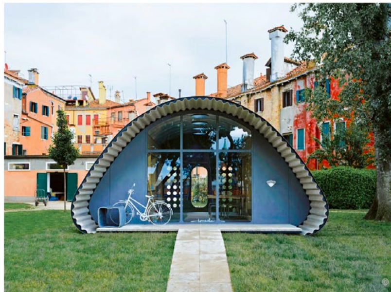
Norman Foster Foundation, Proyecto Essential Homes
