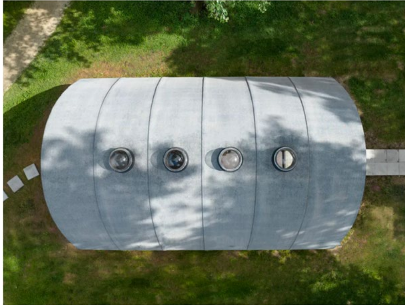
Se garantiza un ambiente interior confortable en cualquier clima. Foto Norman Foster Foundation
